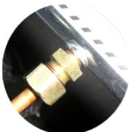
3° - Após feito isto, basta ligar esta parte da válvula na rosca que liga o botão e instalar o segundo cano de cobre no rabicho (rabicho colocado no passo 1):
